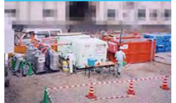
地下水揚水処理によるVOC除去
